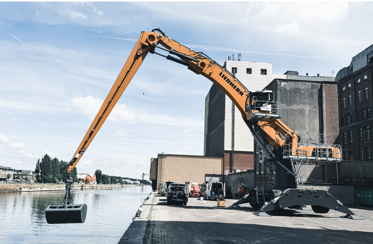
Der Gigant „LH 110 High Rise Port“ im Einsatz
